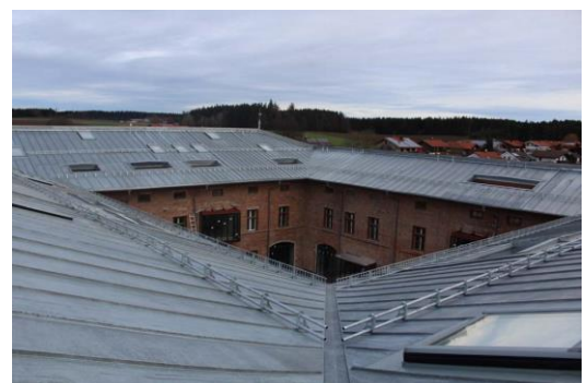
IMG_0342 – Kopie Die Fassaden des in den 1880er Jahren errichteten Gutes Obing wurden denkmalgerecht wiederhergestellt. Das Dach erhielt statt der früheren Stahlbleche eine hochwertige Titanzink-Deckung.. Foto: Schneider M. GmbH
