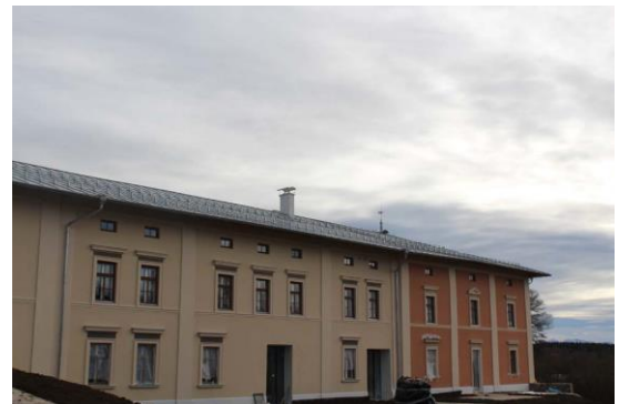
IMG_0342 – Kopie Die Fassaden des in den 1880er Jahren errichteten Gutes Obing wurden denkmalgerecht wiederhergestellt. Das Dach erhielt statt der früheren Stahlbleche eine hochwertige Titanzink-Deckung.. Foto: Schneider M. GmbH
