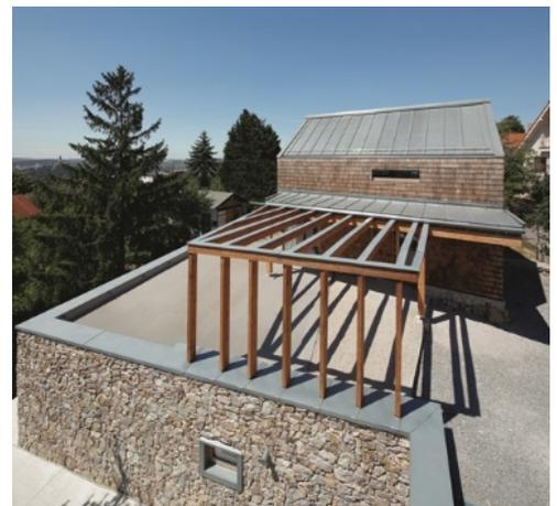
Blick auf die Terrasse: Auf der Oberseite der Sparren dienen exakt angepasste Profile mit Flachschiebenähten als Witterungsschutz.
