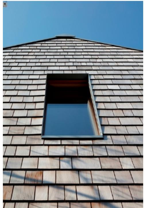
Linsenartige Profile decken den Übergang zwischen Fassade und Fenster so ab, dass nur noch das Glas zu sehen ist.
