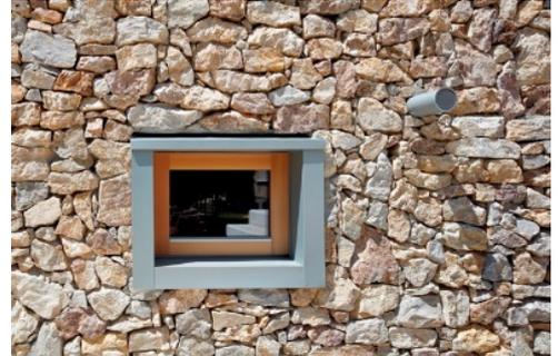
Bei den Fenstern in der Steinfassade überdecken die Fenstereinfassungen die Unregelmäßigkeiten der Bruchsteine und die Blendrahmen.
