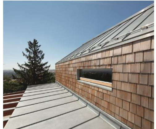
Eine Kappleiste unter der ersten Schindelreihe schützt Fassade und Terrassendach gegen hinterlaufendes Wasser.
