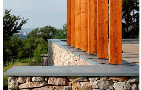
Profile mit Flachschiebenähten und Abdeckkappen bilden den oberen Abschluss bei den Kellerwänden.
