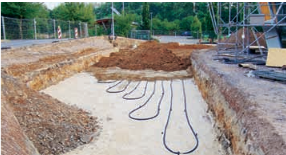
Einbau der Geothermieanlage – ca. 700 m 2 Erdwärmeabsorber in zwei Ebenen
