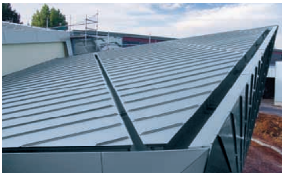
Dachaufteilung mit integrierter Dachentwässerung
