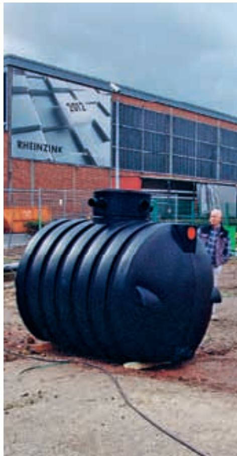
Einbau des nautilus-Regenwassertanks (4 m 3 )
