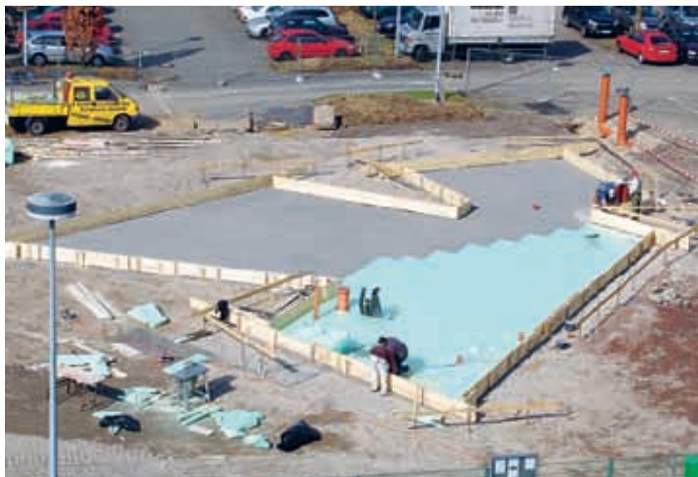
Betonbauarbeiten an der Bodenplatte
