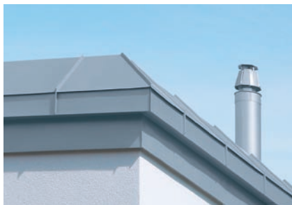
Obróbka dachu płaskiego – wersja uniesiona
