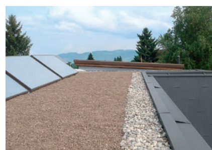
Dach płaski z obróbką gzymsu i dużą łuską na elewacji
