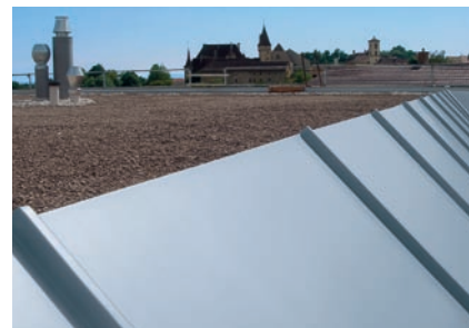
Widok obróbki dachu płaskiego
