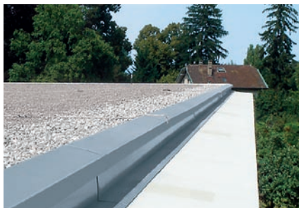
Obróbka dachu płaskiego
