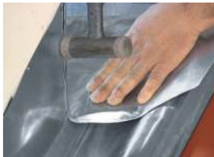
Połączenie kołnierza bocznego z fartuchem
