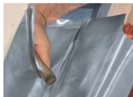
Zawijanie fartucha/kołnierza bocznego
