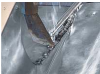
Lutowanie od strony kalenicy
