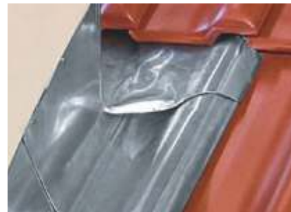
Gotowa obróbka od strony kalenicy
