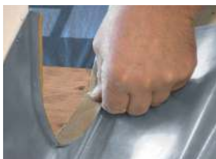
Przygotowanie połączenia klejonego
