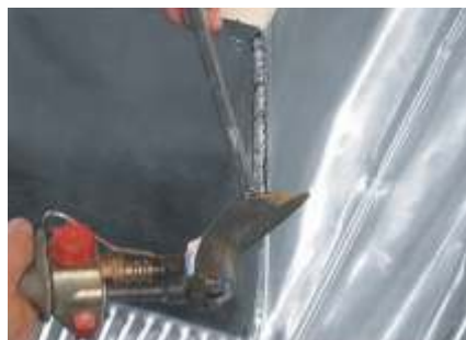
Lutowanie od strony okapu
