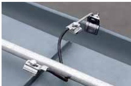
Instalacja odgromowa Ruchome łączenie do rąbka
