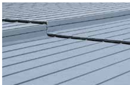
Połączenie poprzeczne: uskok z rąbkem leżącym
