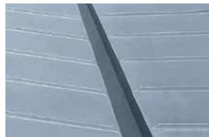
Rynna wewnętrzna skrzynkowa z wyklejaną rynną zabezpieczającą
