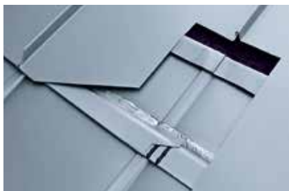
Optymalne wykonanie: dodatkowy pas włutowany
