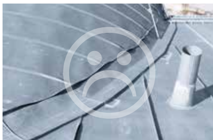
Kosz z bocznymi połączeniami na rąbek
