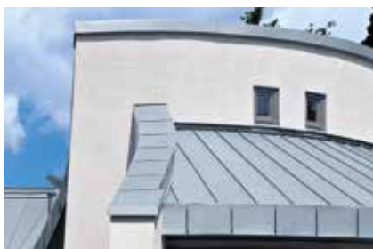
Techniki łączenia zapewniające ruch blachy
