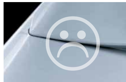
Kalenica dachu jednospadowego bez zapasu na rozszerzenie i o zbyt małym odgięciu do góry
