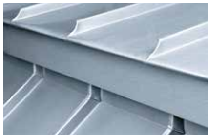
Połączenie poprzeczne: uskok z rąbkem przetamany
