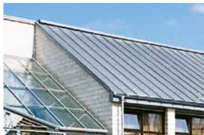
Kalenica dachu jednospadowego na listwę
