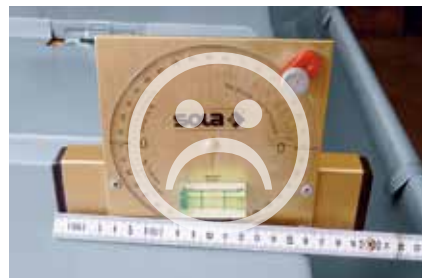
Okap na deskowaniu – niewłaściwe wykonanie detalu
