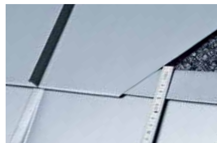
Połączenie poprzeczne: rąbek pojedynczy
