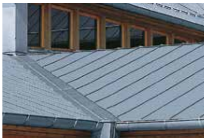
Kosz z rąbkim pojedynczym oraz pasem włutowanym
