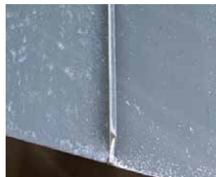
Beispiele für Salzablagerungen auf Fassaden, an Falzen und Tropfkanten
