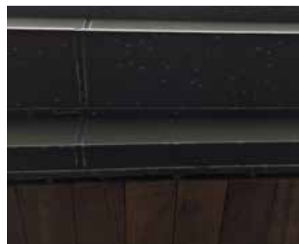
Beispiele für Salzablagerungen an Dachuntersichten und Unterseiten von Dachrinnen
