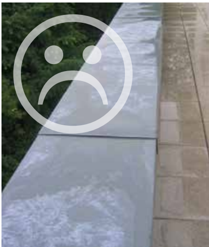
Bildung von Zinkhydroxid durch unzureichendes Gefälle
